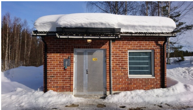
Figur 1. Bild på vattenverket i Niemisel.
