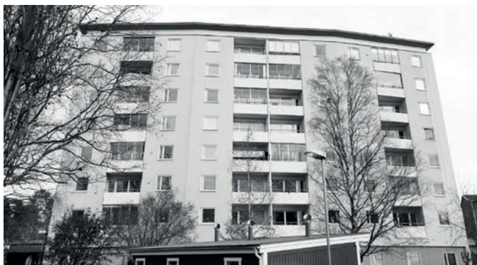
Befintligt tidstypiskt punkthus i Mjölkuddens Centrum
