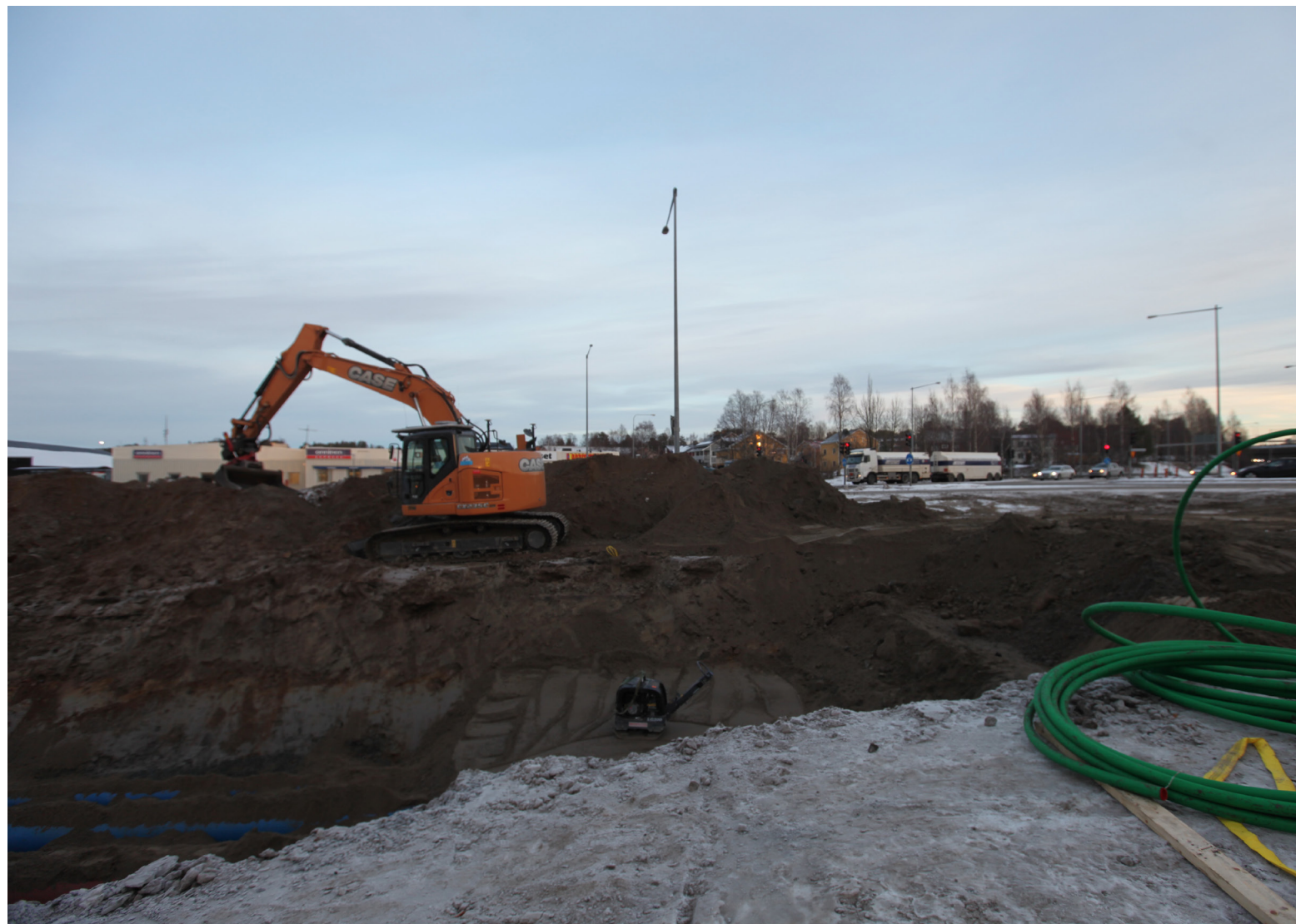
Schaktning av mark. Foto: Frank Rizo
